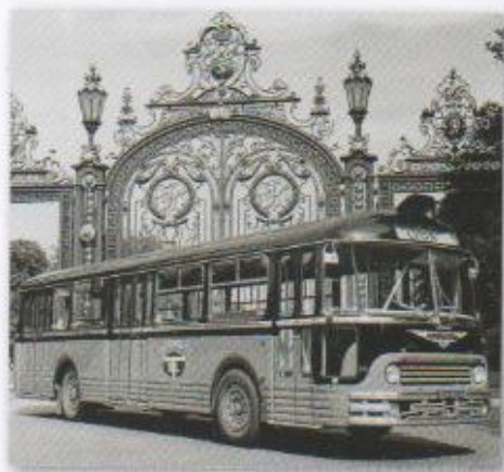
En 1956, l'APV, dont le pavillon est rehaussé de 18 cm afin d'offrir aux passagers debout davantage de visibilité et d'aération.
